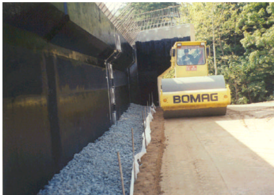
사진 A.75 배수층, 무진동 다짐구간 시공 광경
