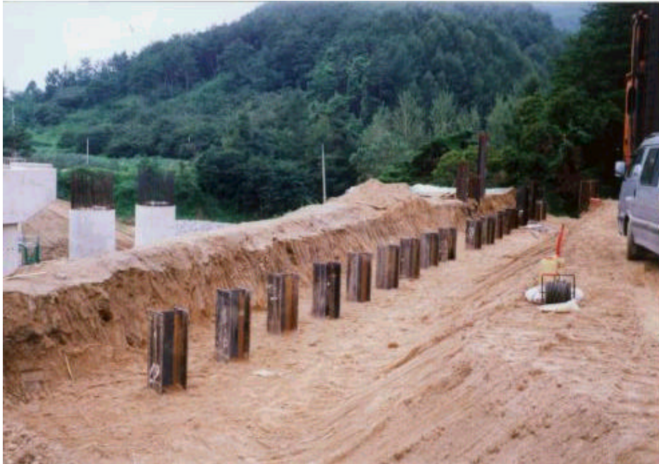
사진 A.29 말뚝향타가 종료된 교대 말뚝(교대 1)의 모습
