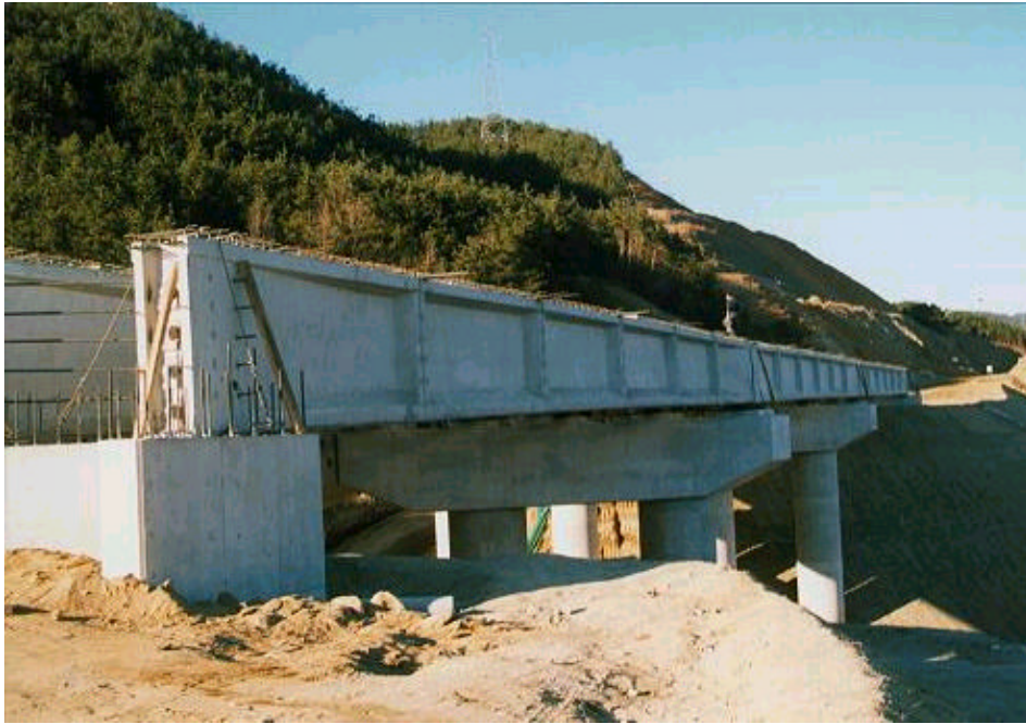
사진 A.47 PSC Beam 거치 후 A2 상행선 측면에서 바라본 모습
