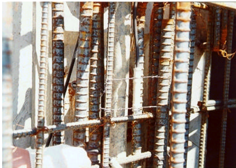
사진 A.73 매설형 콘크리트 게이지가 설치된 교대벽체 철근배근 모습(빔 바로 배면)
