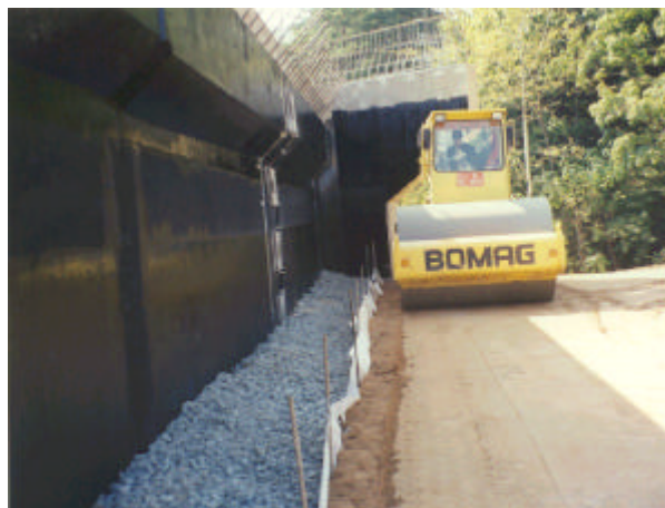
사진 A3.1 배수층, 무진동 다짐구간 시공 광경
