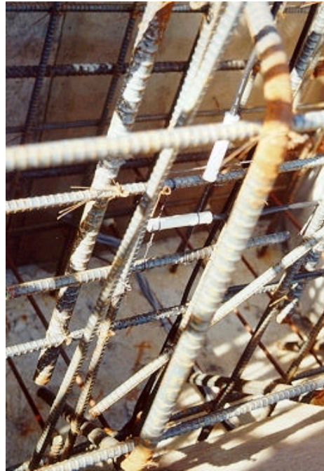
사진 A.72 매설형 콘크리트 게이지가 설치된 교대벽체 철근배근 모습(빔과 빔 사이)
