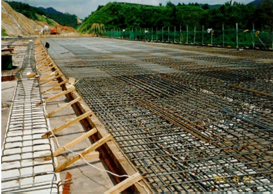
사진 A.55 철근 배근후의 바닥판의 모습
