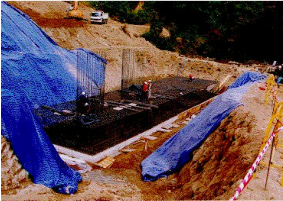
사진 A.11 교각 1의 기초 콘크리트의 철근 배근이 완료된 모습
