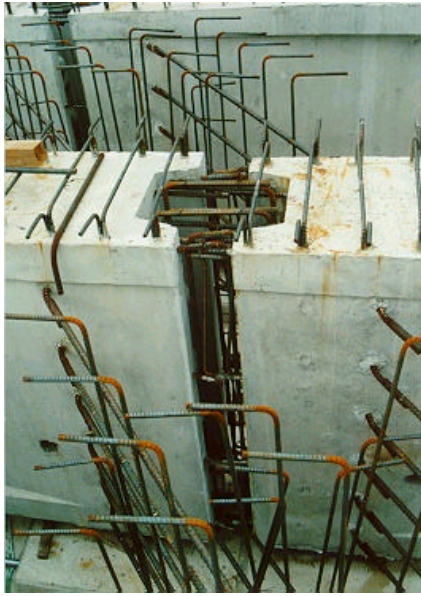
사진 A3.6 PSC Beam 단부에서의 중간격벽 철근배근 및 빔단부 연결철근의 모습
