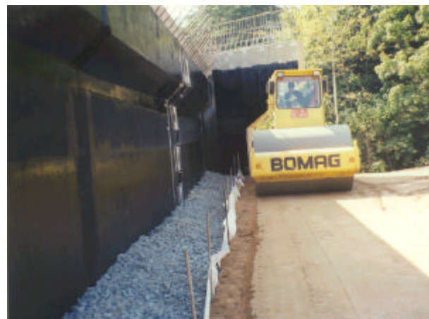
사진 6.2 배수층, 무진동 다짐구간 시공 광경(A1)
