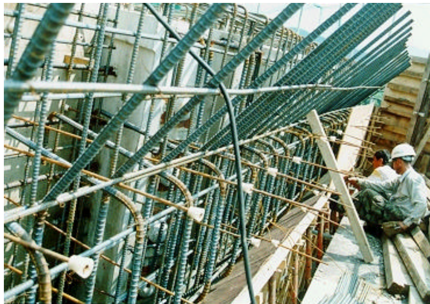
사진 A.57 교대 벽체의 철근 배근 모습(접속슬래브 힙지 철근)
