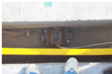
사진 6.6 접속슬래브와 완충슬래브 사이의 조인트미터 설치 장면
