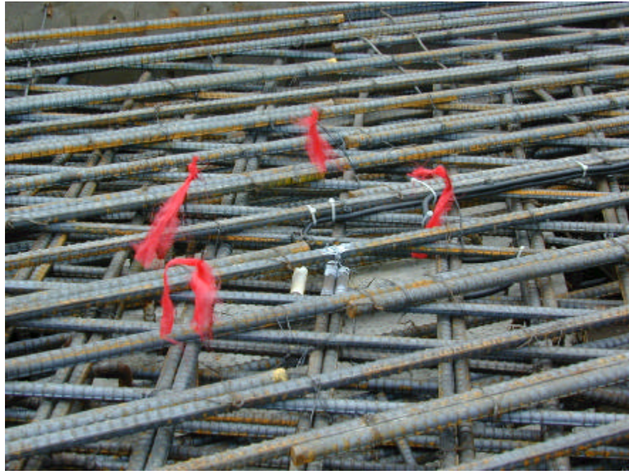
사진 A.68 매설형 콘크리트 게이지가 설치된 상부 바닥판 철근의 모습
