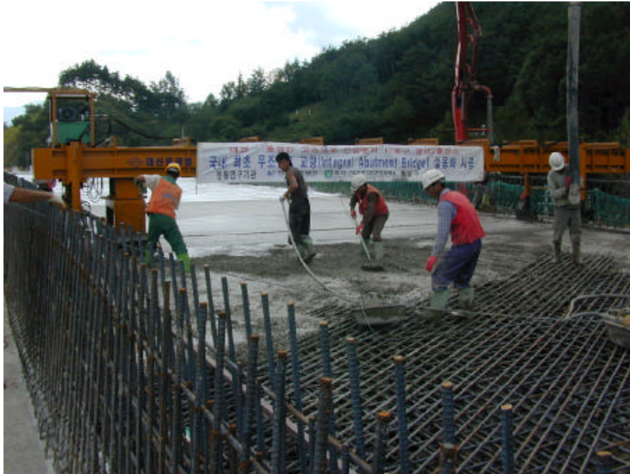
사진 A.60 평촌1교 상부 바닥판 콘크리트 타설 모습
