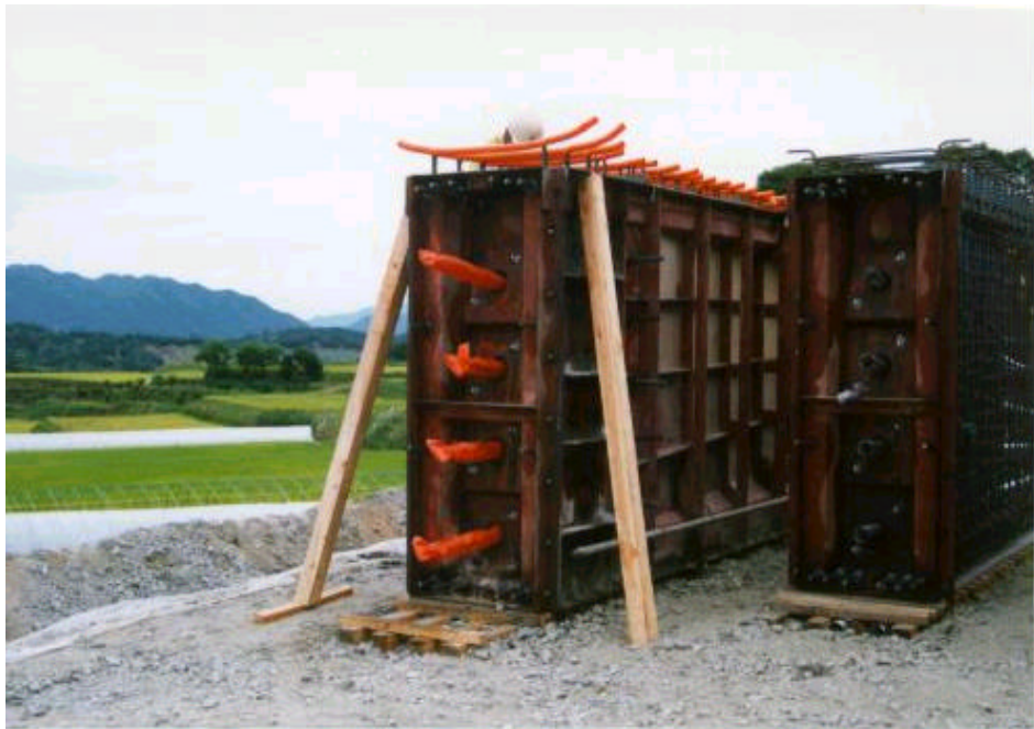
사진 A.40 콘크리트 타설 직전의 PSC Beam의 모습
