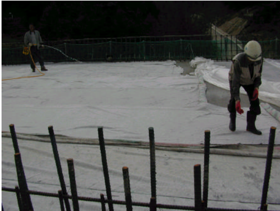
사진 A.64 타설 완료된 바닥판에 양생포로 덮는 모습
