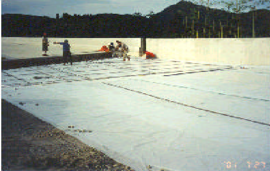
사진 A.85 현지철근 보강 후 철근배근이 완료된 접속슬라브 모습
