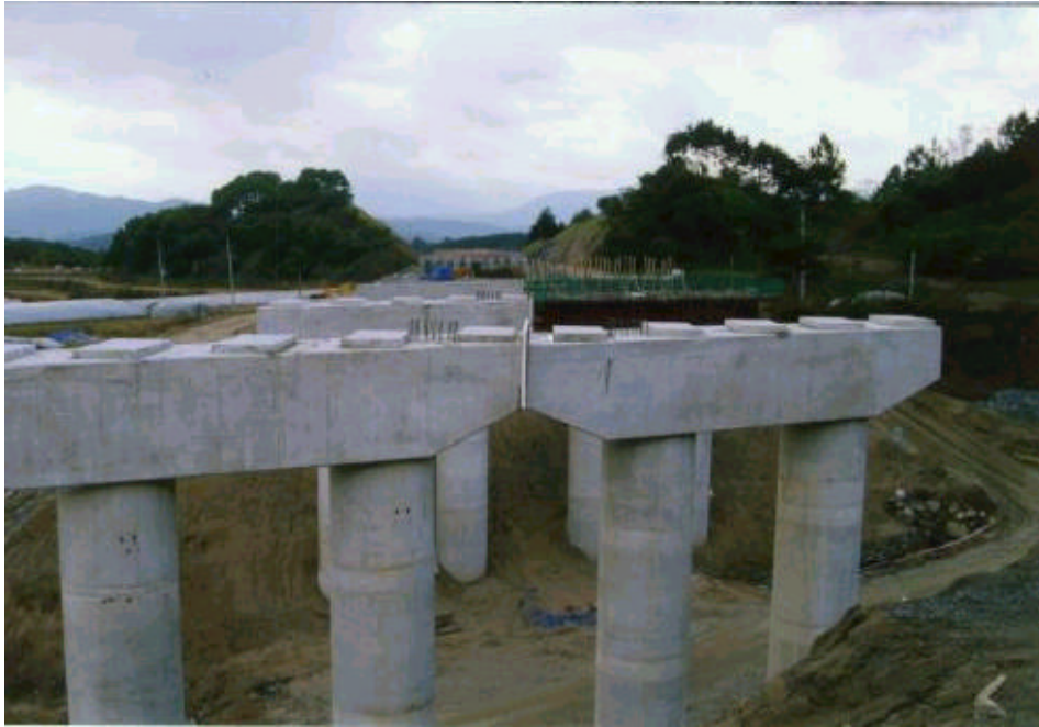
사진 A.20 교각 1의 코핑부 콘크리트 양생 완료 모습
