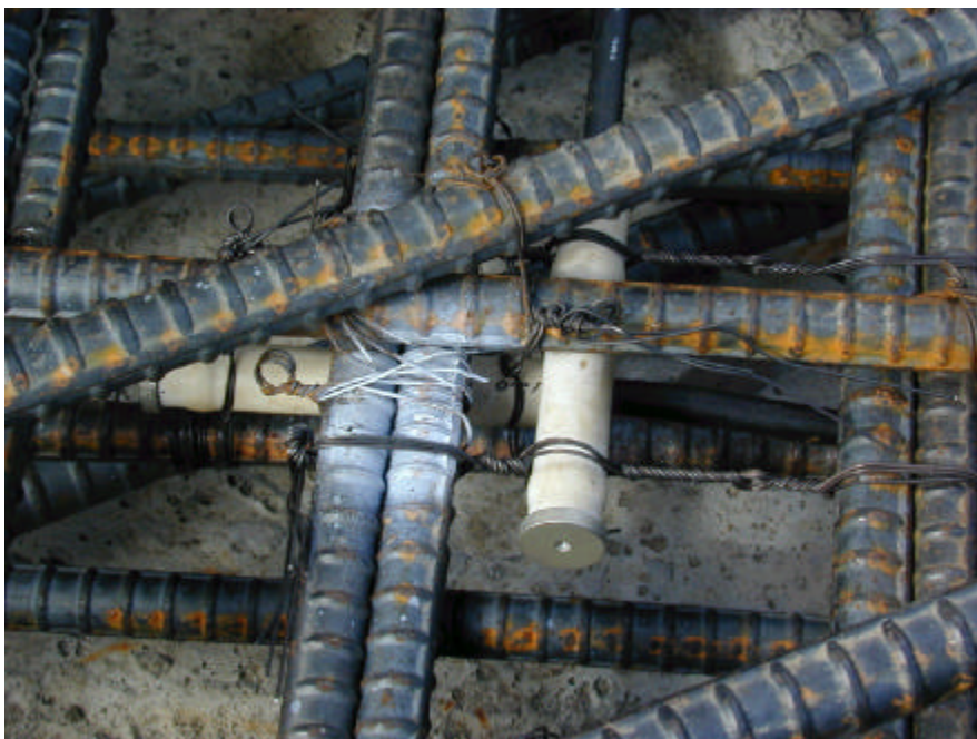
사진 A.71 매설형 콘크리트 게이지가 설치된 상부 바닥판 철근의 모습
