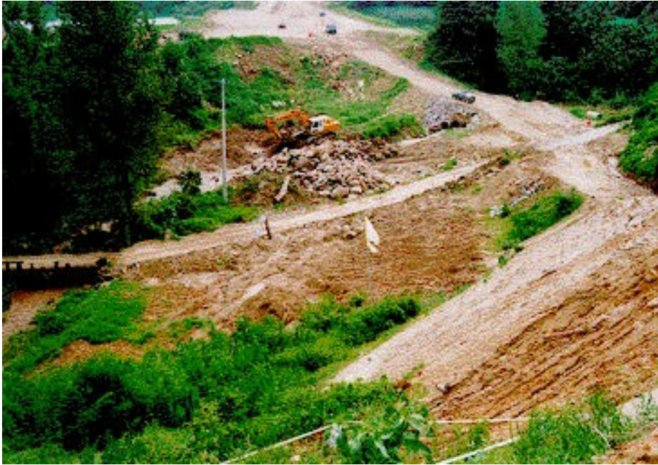
사진 A.4 평촌1교 시공 전 모습
