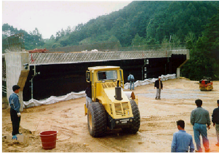
사진 A.78 진동로울러를 사용하여 뒤채움 다짐을 실시하고 있는 모습
