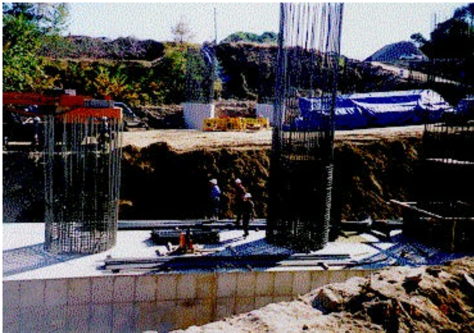
사진 A.12 교각 1, 2의 기초부 시공 전경(교각 1에서 바라본 모습)
