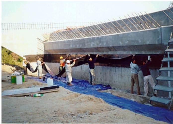
사진 A3.5 교대배면 방수시트 시공모습
