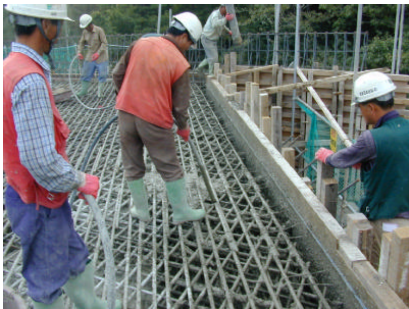
사진 A3.8 하부구조와 상부주형을 일체화시키는 교대부 콘크리트 타설 전경
