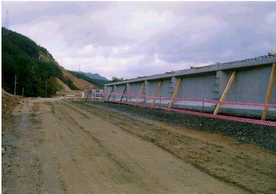
사진 A.45 완성된 PSC Beam 모습
