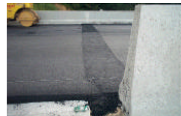
사진 6.6 접속슬래브와 완충슬래브 사이의 조인트미터 설치 장면
