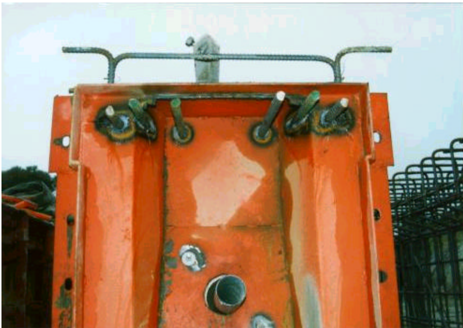
사진 A.42 PSC Beam 단부의 상부 연결철근
