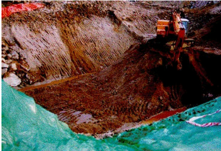
사진 A.5 교각 2의 기초 터파기를 수행하고 있는 모습
