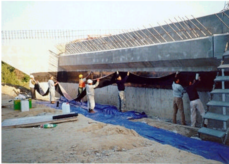
사진 A.74 교대배면 방수시트 시공모습
