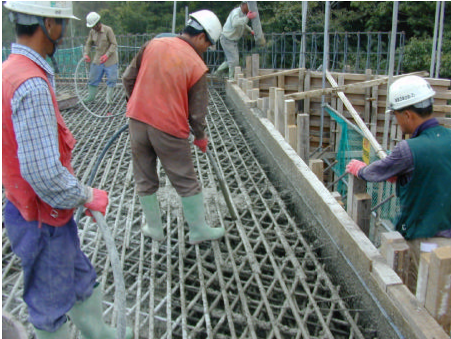
사진 A.62 마지막 단계로 바닥판 및 교대 벽체를 일체로 타설하는 모습(하행선, A1)
