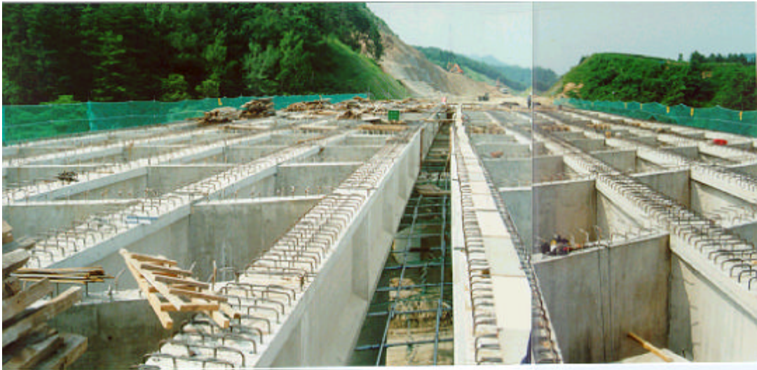
사진 A.53 거푸집 탈형후의 중간격벽이 완성된 평촌1교의 전경
