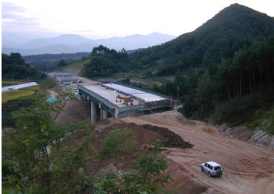
사진 A.67 상부 바닥판 콘크리트가 모두 타설 완료된 평촌1교 전경
