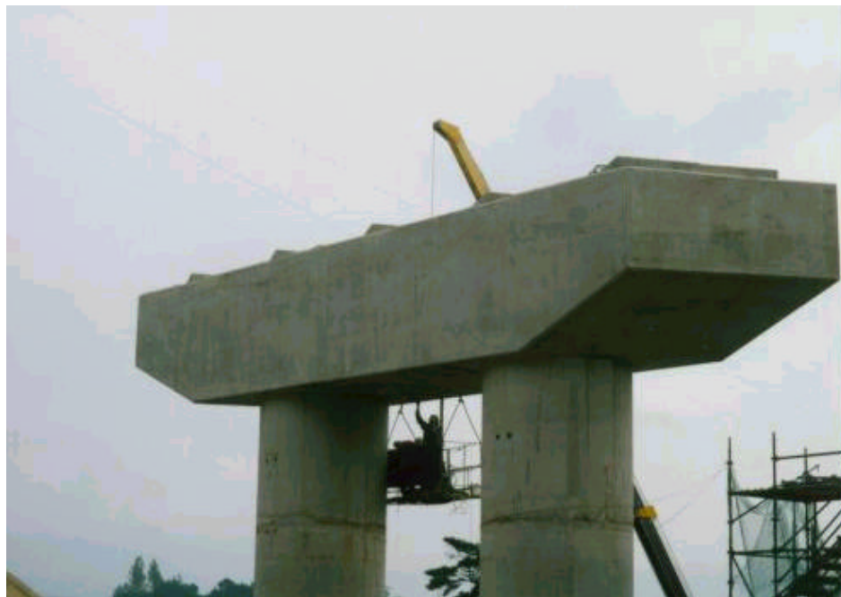
사진 A.21 시공 완료된 교각 코핑부의 확대 모습
