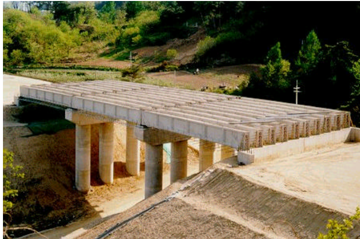
사진 A.49 PSC Beam의 거치가 완성된 평촌1교의 전경
