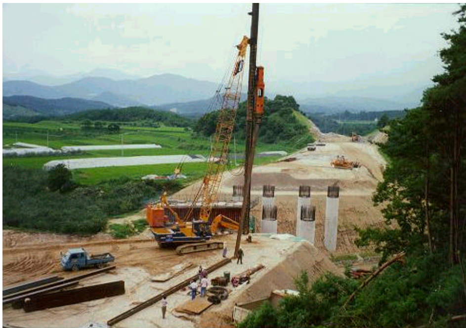
사진 A.28 교대 1의 말뚝 항타 전경
