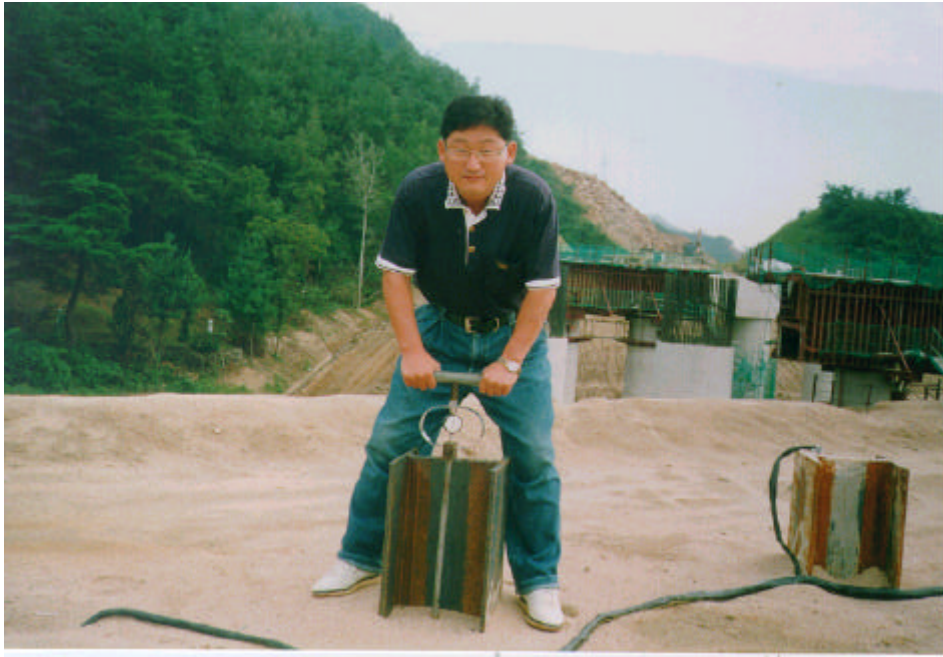
사진 A.33 공동부에 채운 모래에 휴대용 콘관입시험하는 장면
