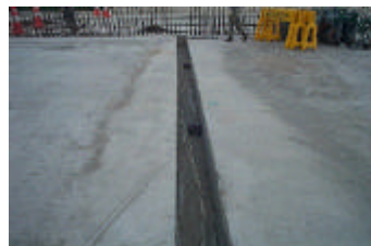
사진 6.6 접속슬래브와 완충슬래브 사이의 조인트미터 설치 장면
