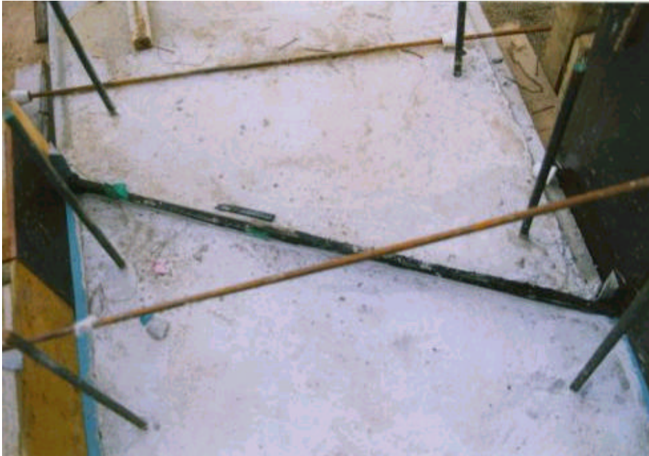
사진 A.39 교대 분리막으로 네오피렌 스폰지를 사용하여 시공한 모습
