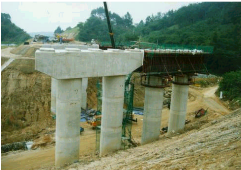
사진 A.19 교각 1의 코핑부 콘크리트 양생 중인 모습
