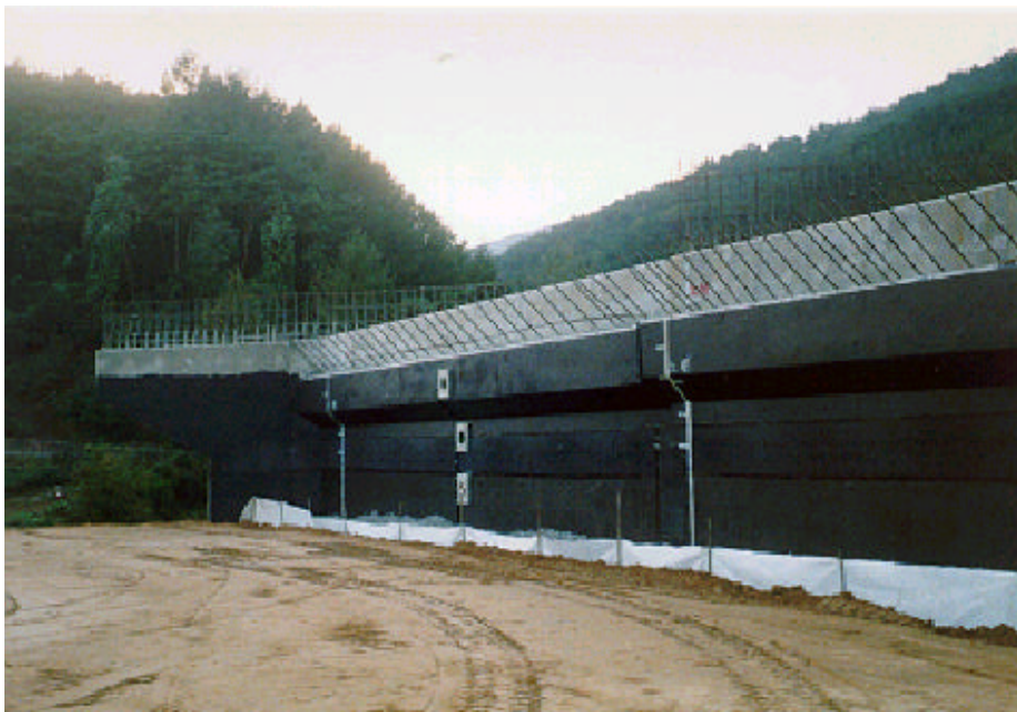
사진 A.81 토압계가 부착된 교대 벽체의 모습(교대 2)
