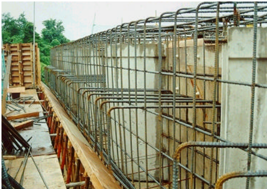
사진 A.56 교대 벽체의 철근 배근 모습(접속슬래브 헌치 철근)
