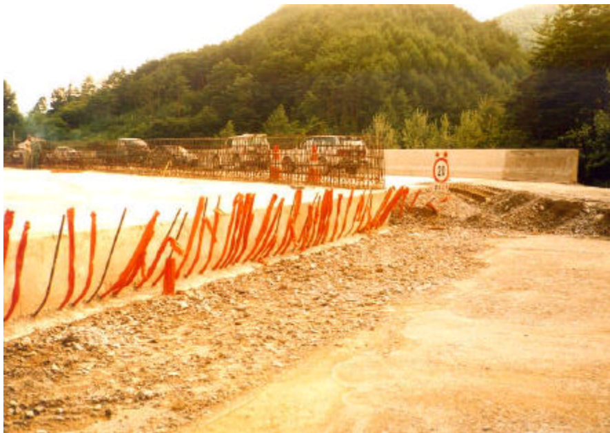
사진 A.83 접속슬래브 연결철근(교대부 힌지 철근) 모습
