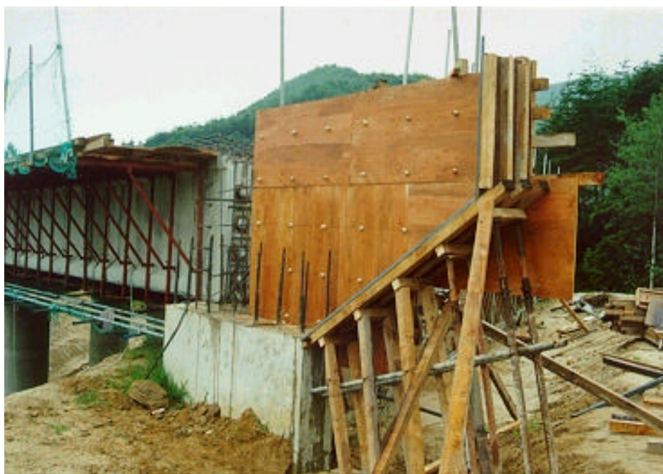
사진 A.58 교대 날개벽 거푸집 모습
