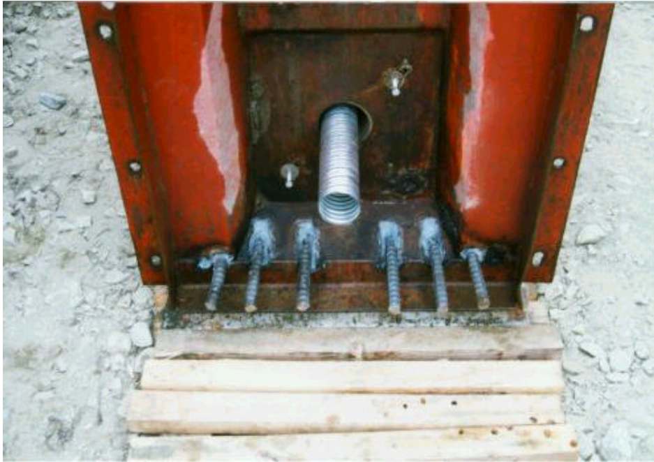
사진 A.43 PSC Beam 단부의 하부 연결철근(콘크리트 타설 전)
