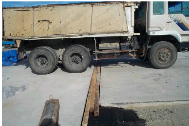
사진 A.87 만재트럭을 이용한 신축조절장치부의 아스콘 다짐
