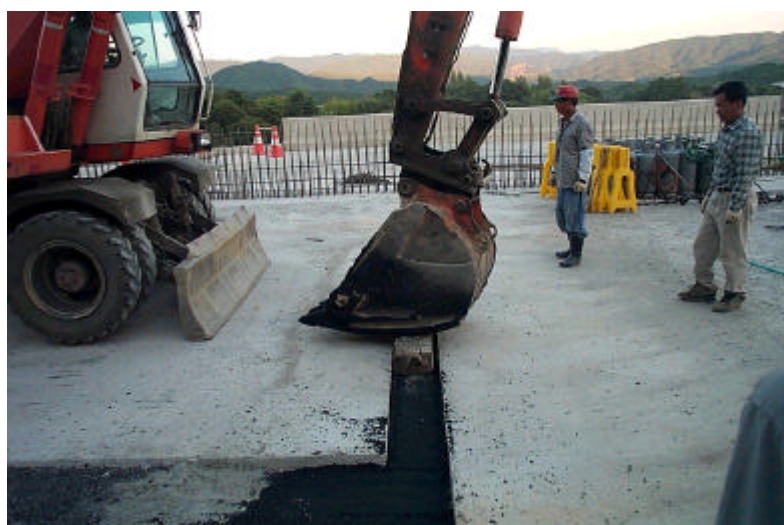
사진 A.87 백호우를 이용한 신축조절장치부의 아스콘 다짐
