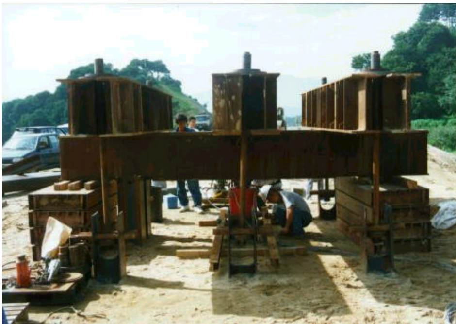
사진 A.31 말뚝의 연직정재하시험(교대 2)
