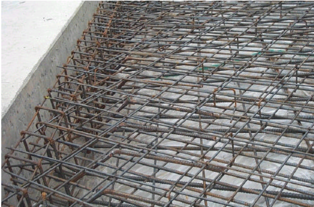
사진 A.84 한지철근 보강 후 철근배근이 완료된 접속슬래브 모습
