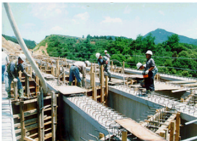
사진 A.52 타설중인 중간격벽 콘크리트 모습
