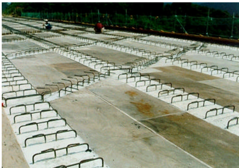
사진 A.54 철근배근전의 바닥판의 모습
