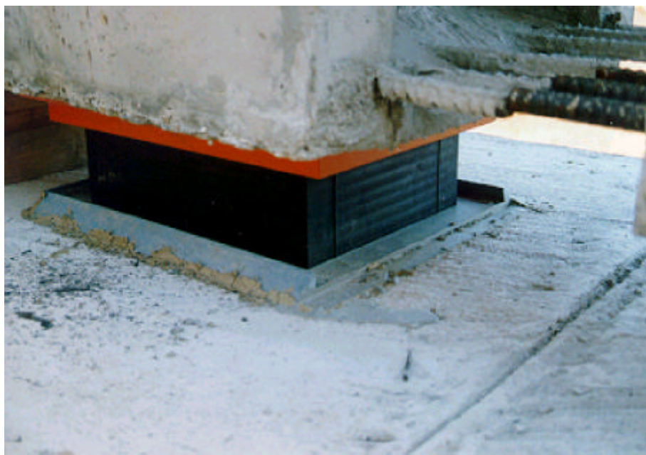
사진 A.46 교각위 PSC Beam이 거치된 탄성고무베어링의 모습
