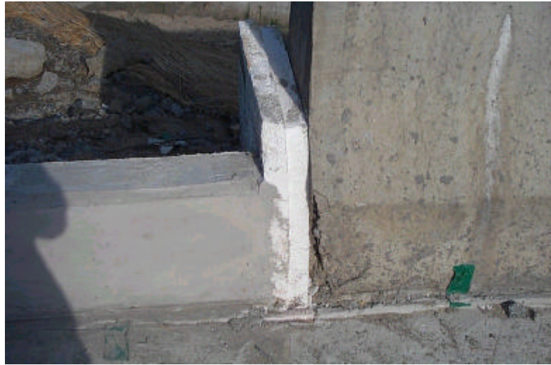
사진 A.90 변위조절을 위한 교량부와 연석 경계 스티로폼 삽입
