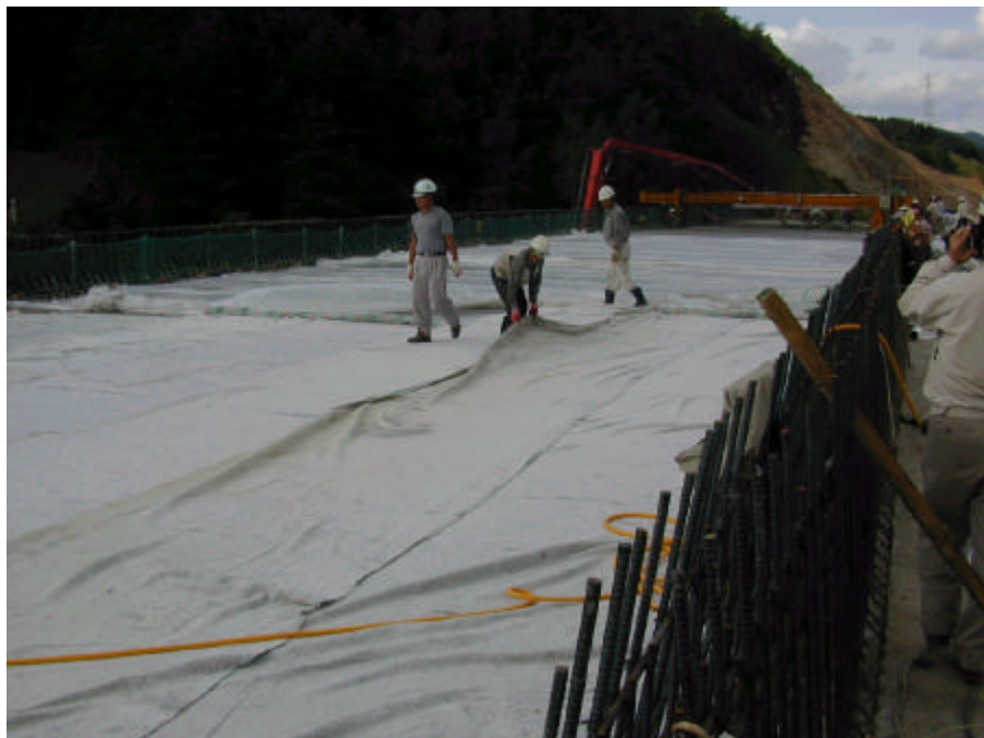
사진 A.65 타설 완료된 바닥판에 양생포로 덮고 양생관리(살수)하는 모습
