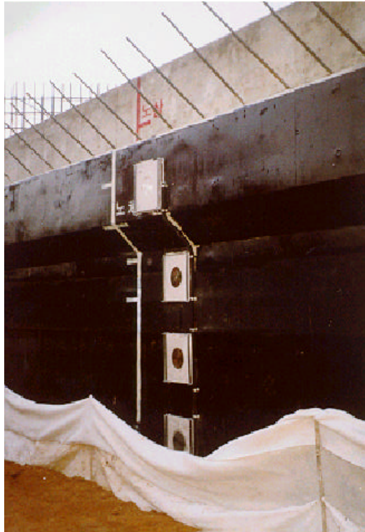
사진 A.82 토압계가 부착된 교대 벽체의 모습(교대 1)
