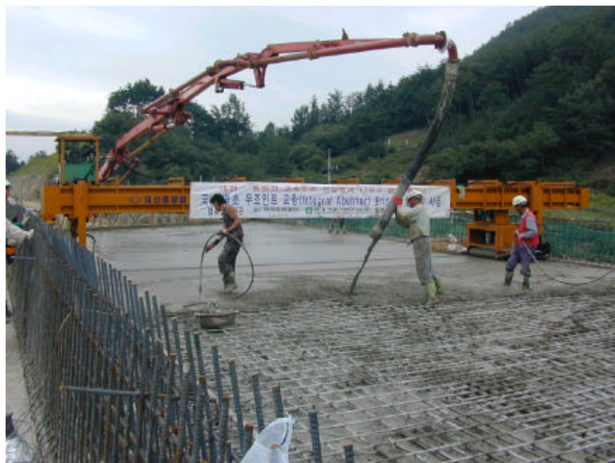
사진 A.59 평촌1교 상부 바닥판 콘크리트 타설 모습(하행선)
