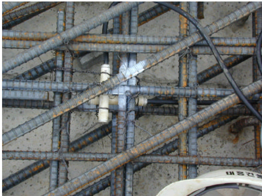
사진 A.69 매설형 콘크리트 게이지가 설치된 상부 바닥판 철근의 모습
