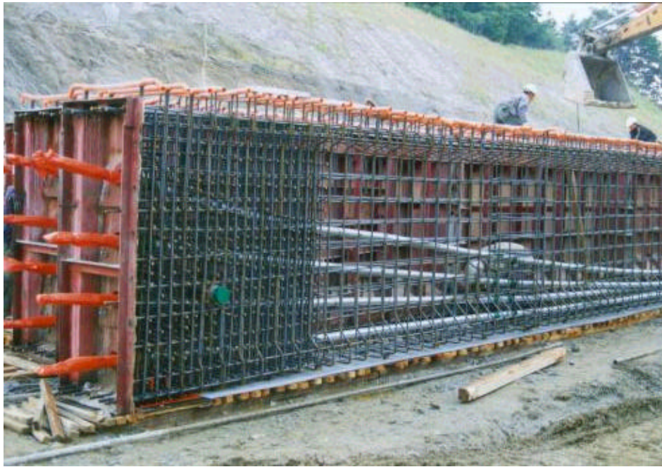
그림 A.16 PSC Beam의 철근배근 모습
