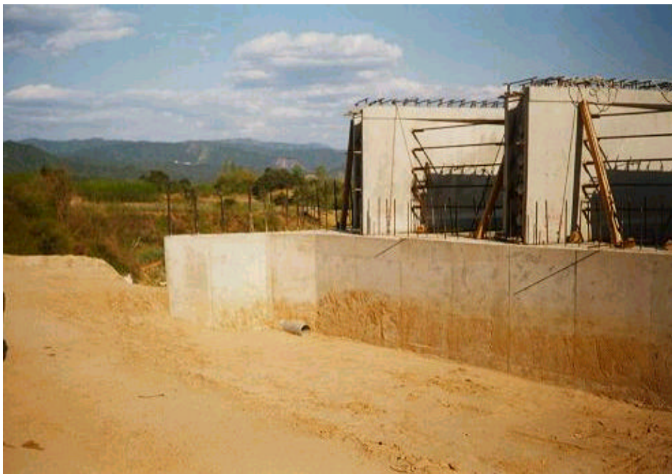
사진 A.48 PSC Beam 거치 후 교대 배면에서 바라본 모습
