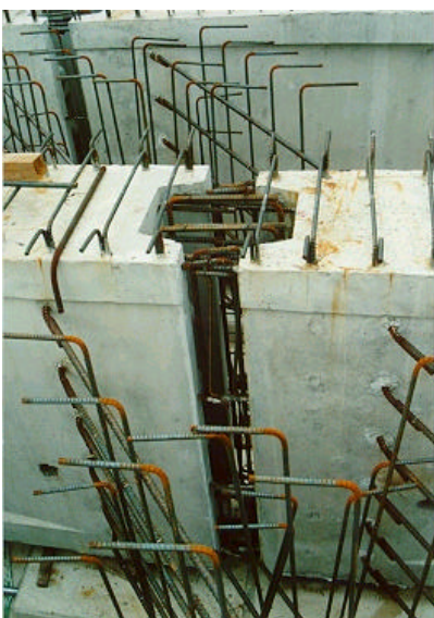
사진 A.50 PSC Beam 단부에서의 중간격벽 철근배근 및 빔단부 연결철근의 모습
