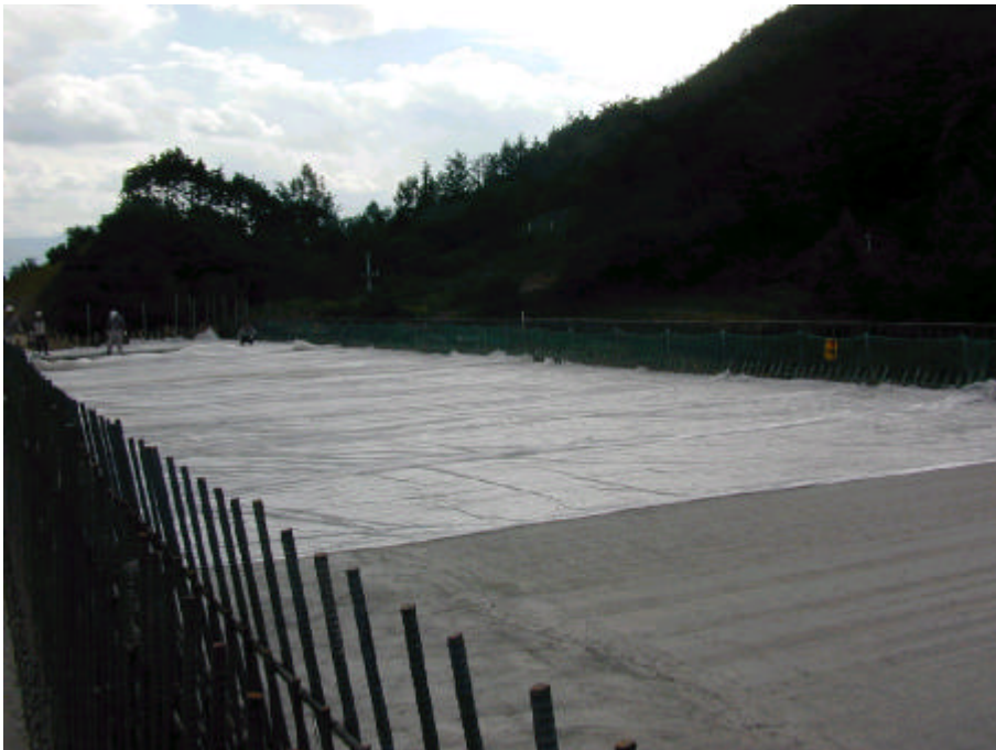
사진 A.63 타설 완료된 바닥판을 약 2~3시간 경화 후 비닐을 덮어 양생을 준비하는 모습
