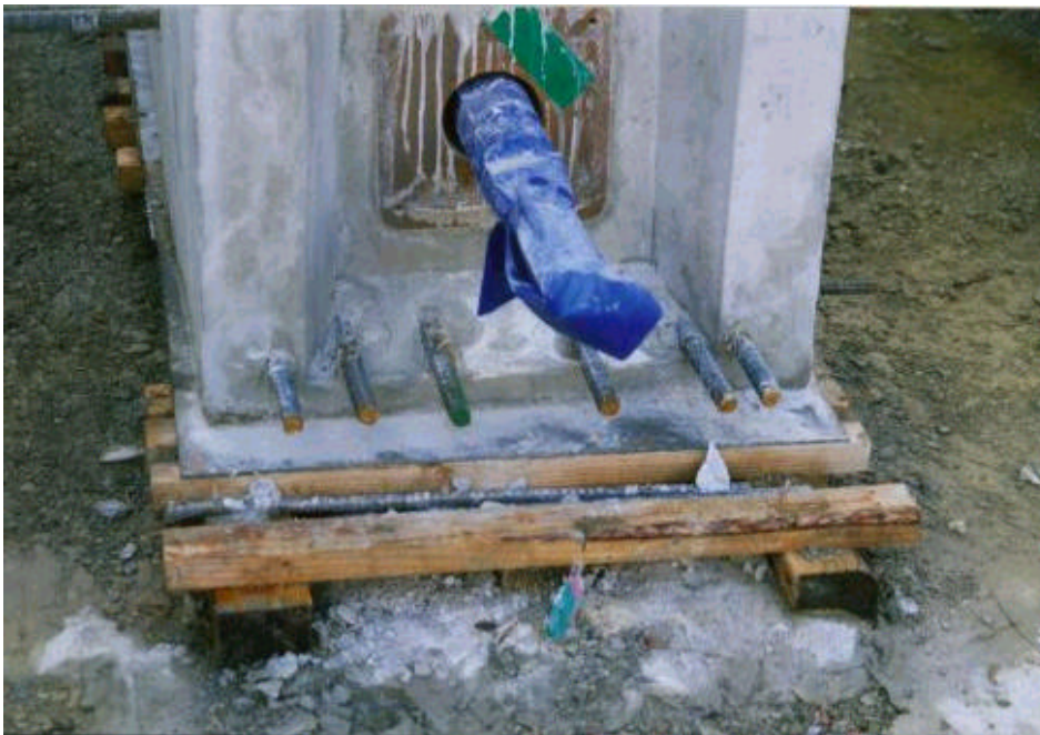
사진 A.44 PSC Beam 단부의 하부 연결철근(콘크리트 타설 후)
