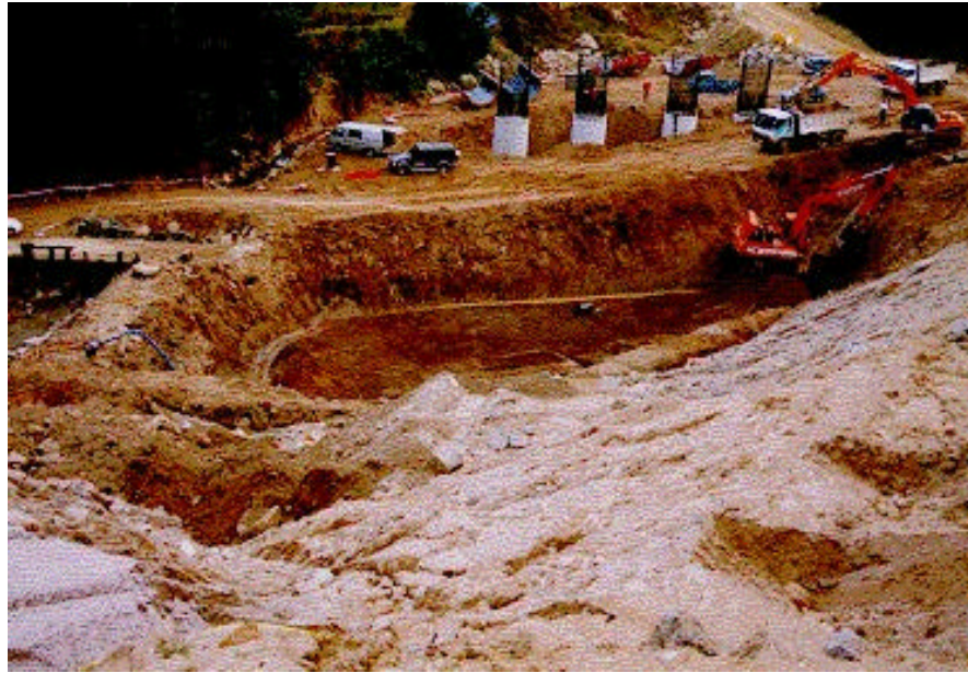
사진 A.9 교각 1의 터파기 공사가 진행중에 있는 모습
