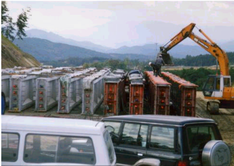
사진 A.41 백호우를 이용한 PSC Beam의 콘크리트 타설 모습
