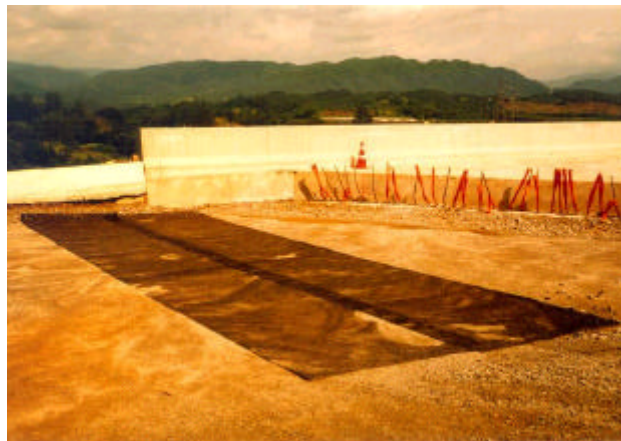
사진 6.3 받침슬래브아래에 지오그리드 설치 장면
