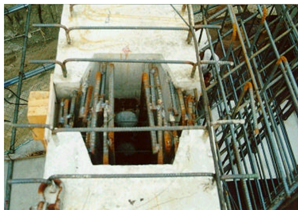
사진 A.50 PSC Beam 단부에서의 중간격벽 철근배근 및 빔단부 연결철근의 모습
