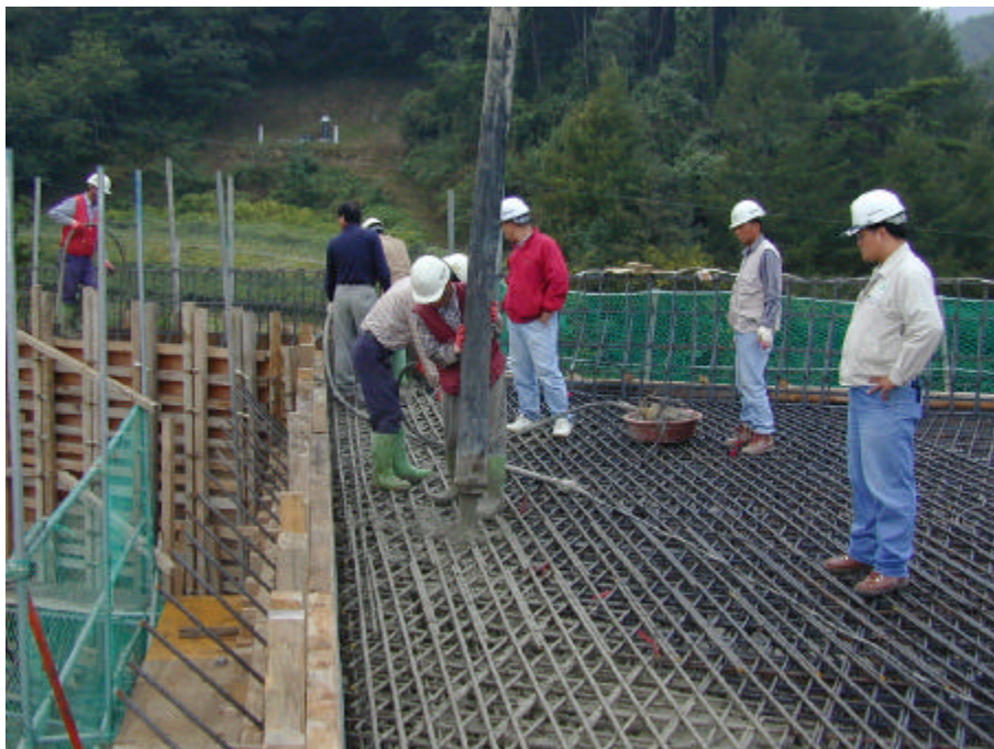
사진 A.61 평촌1교 A2 콘크리트 타설 모습(하행선, 접속슬래브 시팅부까지)
