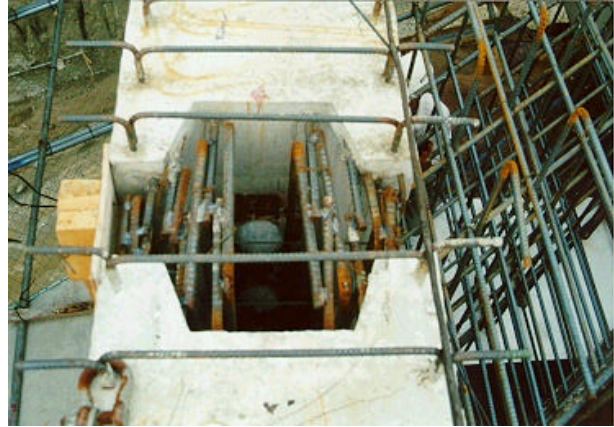
사진 A3.6 PSC Beam 단부에서의 중간격벽 철근배근 및 빔단부 연결철근의 모습
