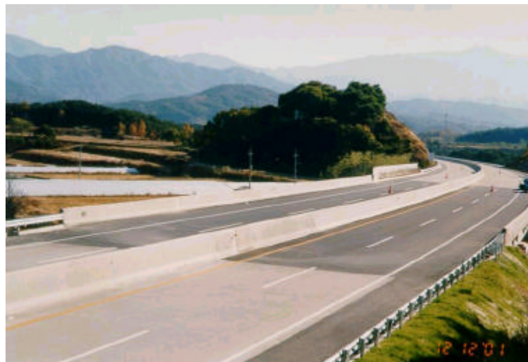
사진 A.91 완공된 무조인트교량 평촌1교 포장 전경
