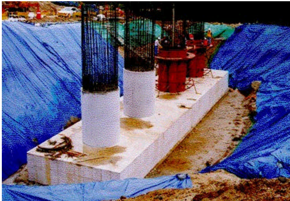
사진 A.8 교각 2의 기둥 하단부 콘크리트 타설이 진행되고 있는 모습
