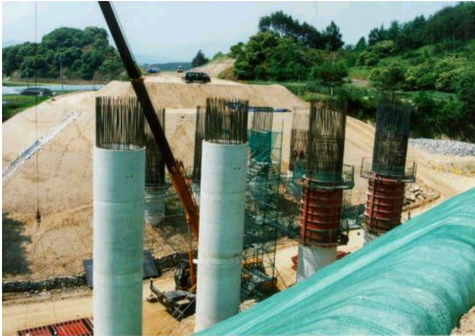
사진 A.18 교각 기둥의 콘크리트 양생 모습
